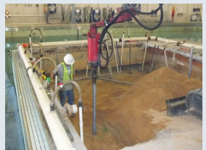
Installing HP288 piles
